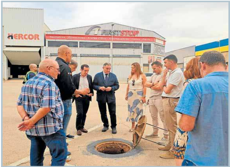
El vicepresidente y conseller para la Reconstrucción visita una red de saneamiento afectada por la dana. LP
