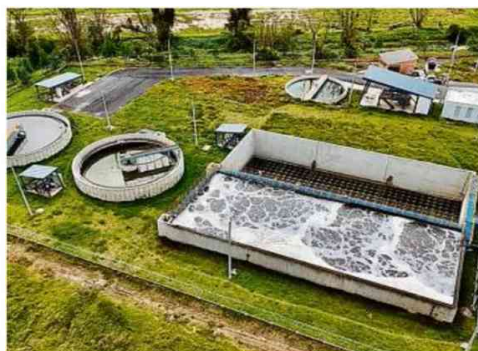
La nueva planta de tratamiento de aguas residuales tiene capacidad para tratar más de 96 litros por cada segundo. FOTO: CAR
